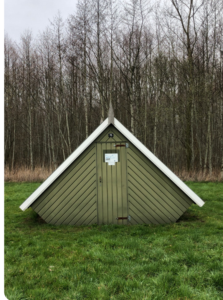
Een zouthuisje bij de caverne in Oost-Nederland. Zouthuisjes dienen ter bescherming van de pijpen die uit de grond komen.
