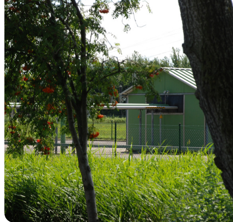
Toegang naar de caverne van de Duitse opslaghouder, het begin van 1,5 kilometer pijpleiding.
