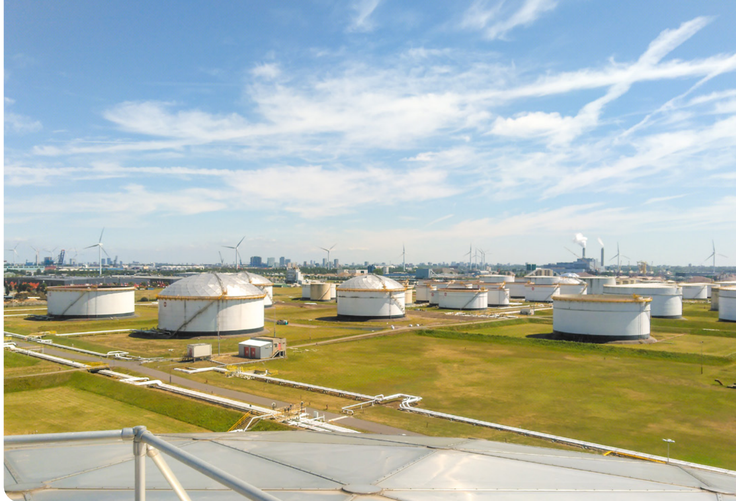
Tanks terminal Noord-Nederland (Beeld: Ministerie van Economische Zaken)
